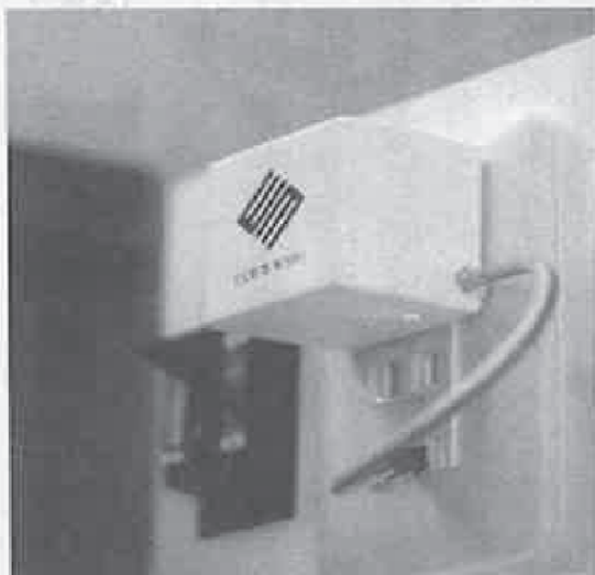
感震ブレーカー「瞬断」
