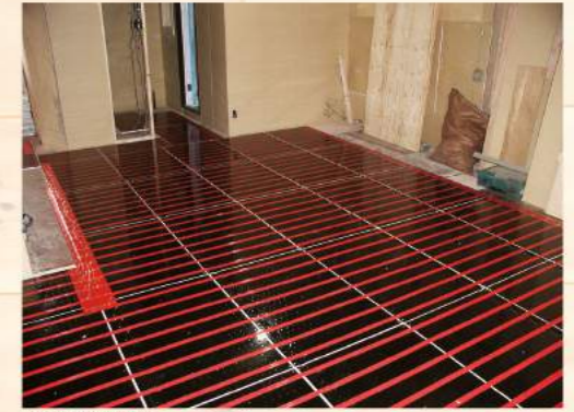
パネル施工完了
