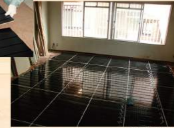
パネル敷込み
